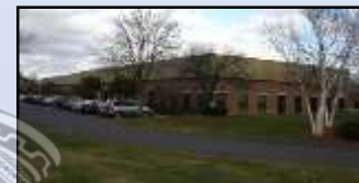
East Granby, CT Manufactura de analizadores de gases
