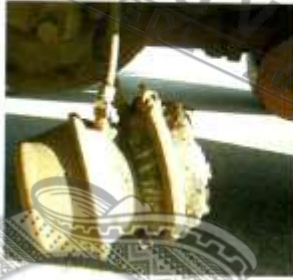
a. (5) (b) Loose Brake Chamber
